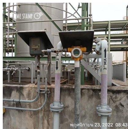
ภาพที่ 2-28 Gas Detector และ Ammonia Detector
