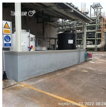
ภาพที่ 2-26 คันคอนกรีตป้องกันการหกรั่วไหลของสารเคมี
