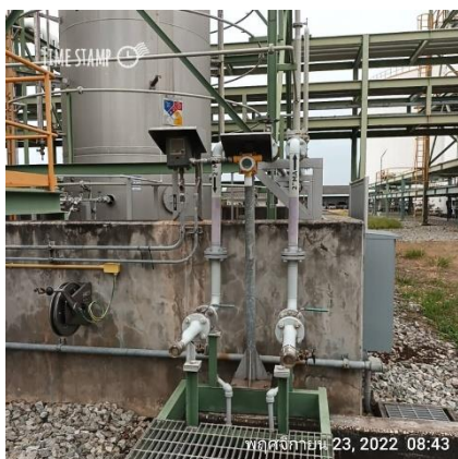
ภาพที่ 2-28 Gas Detector และ Ammonia Detector
