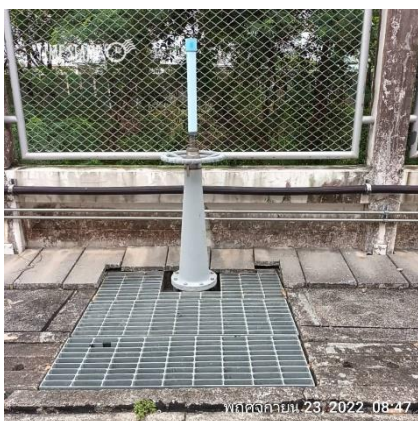
ภาพที่ 2-12 ประตูปรับน้ำทั้งและน้ำฝนของโครงการ
