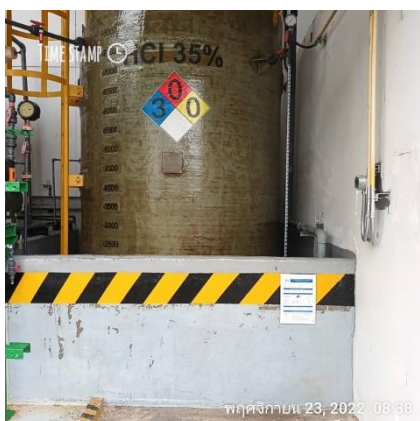
ภาพที่ 2-26 คันคอนกรีตป้องกันการหกรั่วไหลของสารเคมี
