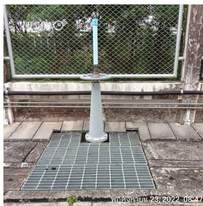
ภาพที่ 2-12 ประตูปรับน้ำทั้งและน้ำฝนของโครงการ
