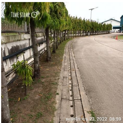
ภาพที่ 2-11 รางระบายน้ำฝนในพื้นที่โครงการ
